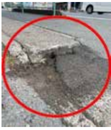
アスファルトによる補修
