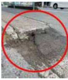
アスファルトによる補修
